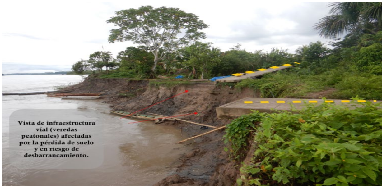
FIGURA N°02: AFECTACIÓN DE VEREDA PEATONAL POR EROSIÓN FLUVIAL
