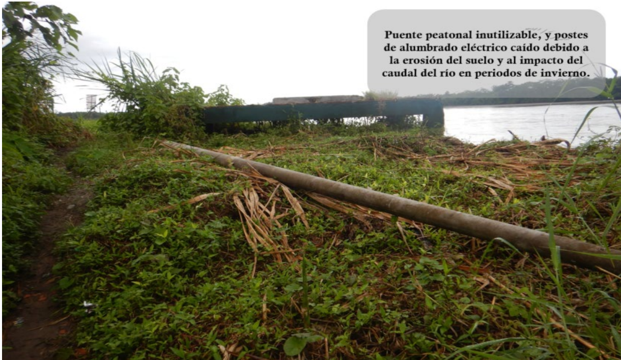
FIGURA N°05: AFECTACIÓN DE PUENTE PEATONAL Y ALUMBRADO ELÉCTRICO
